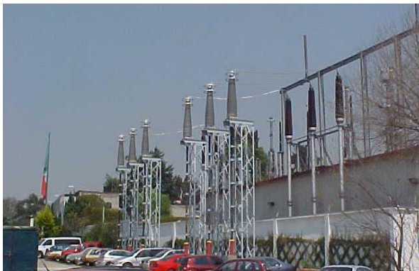
Figura 9.- Terminales para cable subterráneo
