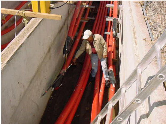
Figura 8.- Pruebas preliminares de instalación
