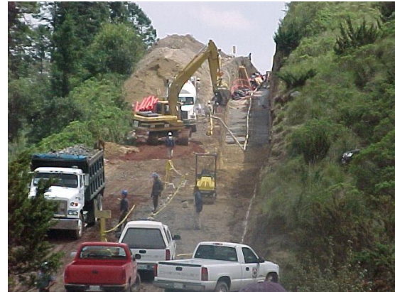
Figura 7.- Instalación de un cable subterráneo
