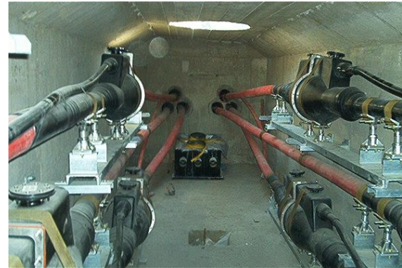
Figura 10.- Empalmes para cables subterráneos
