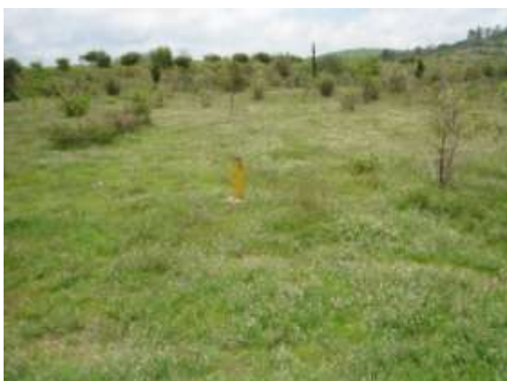
Figura VIII-14 Estado actual de la presa de jales
