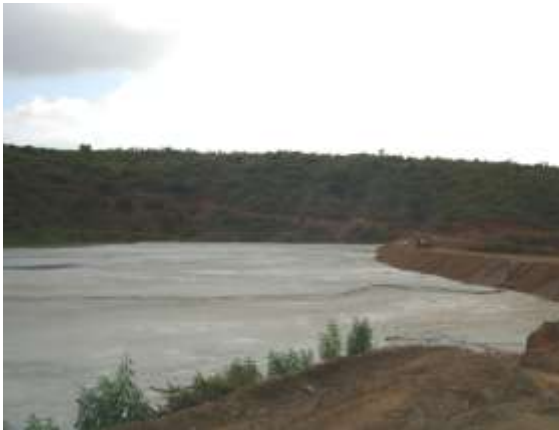
Figura VIII-4 Cortina de la presa de jales de la mina Bolañitos.
