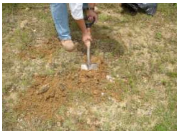
Figura VIII-15 Cubierta de tepetate en el vaso de la presa.
