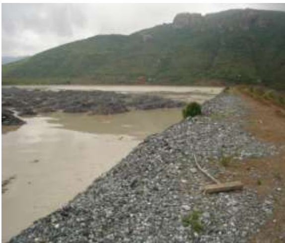
Figura VIII-2 Presa de jales en operación, método de operación por flotación "bulk".
