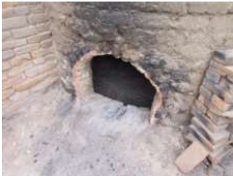
Figura 6. Puerta de alimentación de combustible
