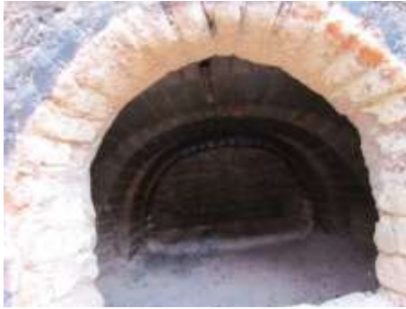
Figura 4. Caldera o cocina, horno MK2
