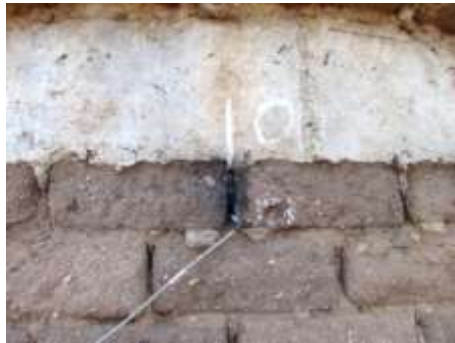
Figura 16. Perforaciones para termopares.
