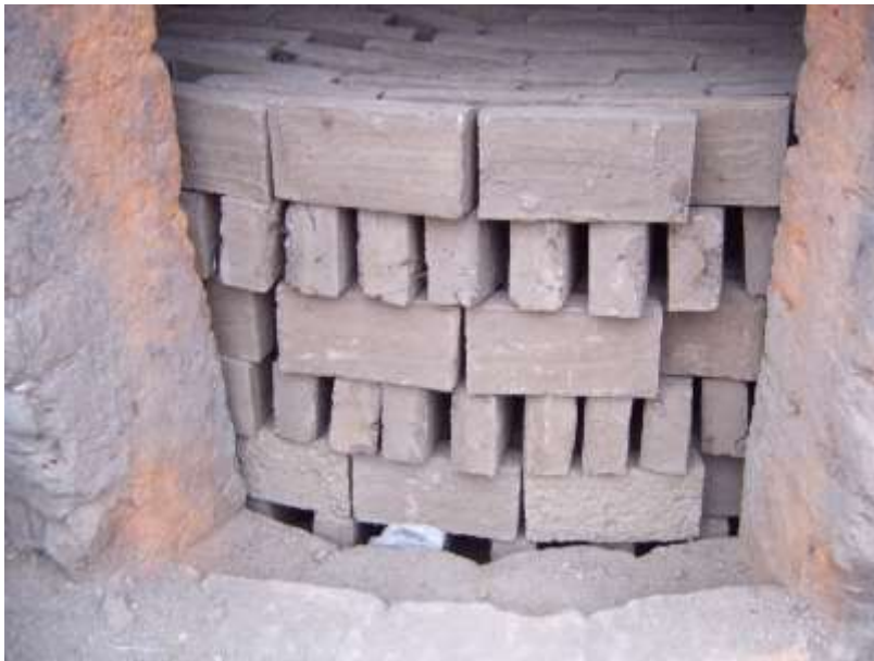
Figura A5. Vista de la configuración de ladrillos desde la puerta por donde se carga el ladrillo.
