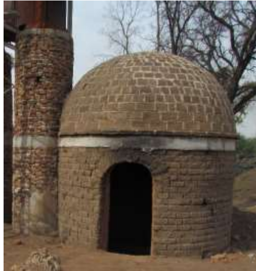
Figura 10. Chimenea de horno MK2.
